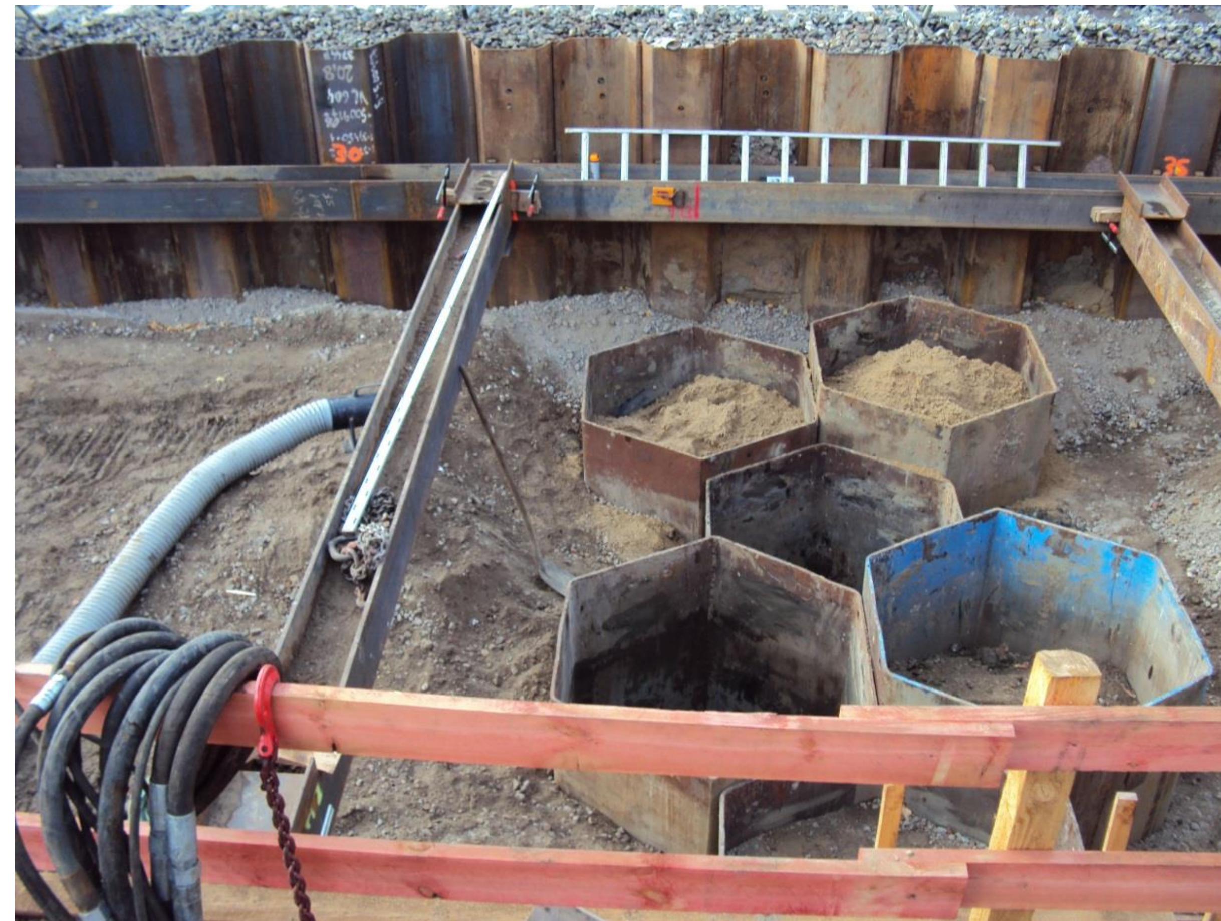
Abb. 5: Wabenverfahren zur Bodensanierung
