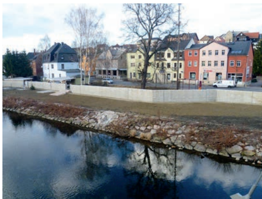
Abb. 3.13: Blick auf die fertiggestellte Hochwasserschutzmauer (Foto: I. Callsen).
