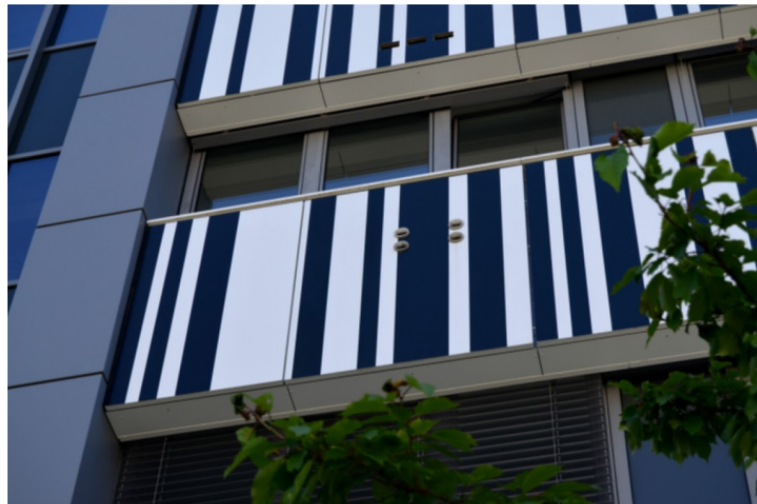
Abbildung 7 Einflugöffnungen für Fledermausquartiere am Haus 14 (2013)
