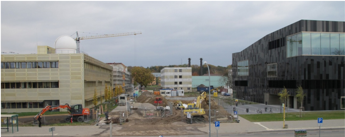
Abbildung 5 Laufende Bauarbeiten auf dem Campus „Golm“ (2013)
