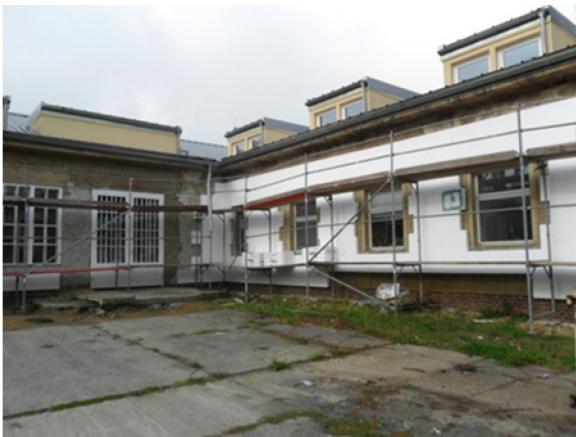
Beginn der Baumaßnahmen (2011)
