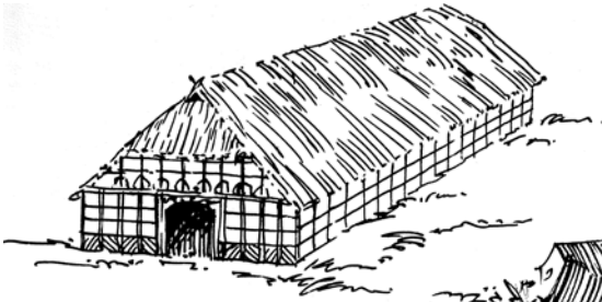
Fig. 4 Norddeutscher Einfirsthof (niederdeutsches Hallenhaus)
