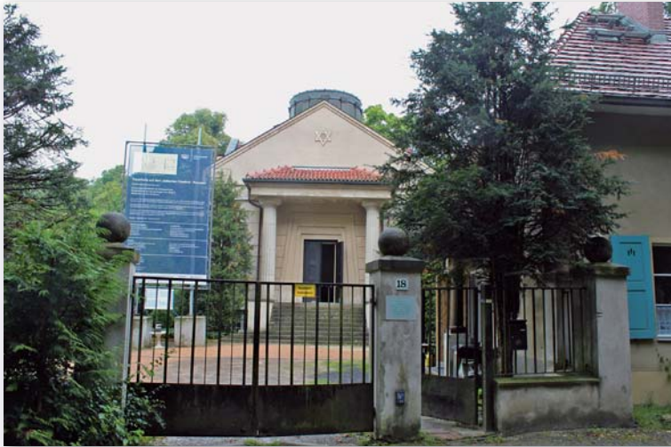
Abb. 7: Trauerhalle und Gärtnerhäuschen mit Restaurierungs-Aufsteller.
