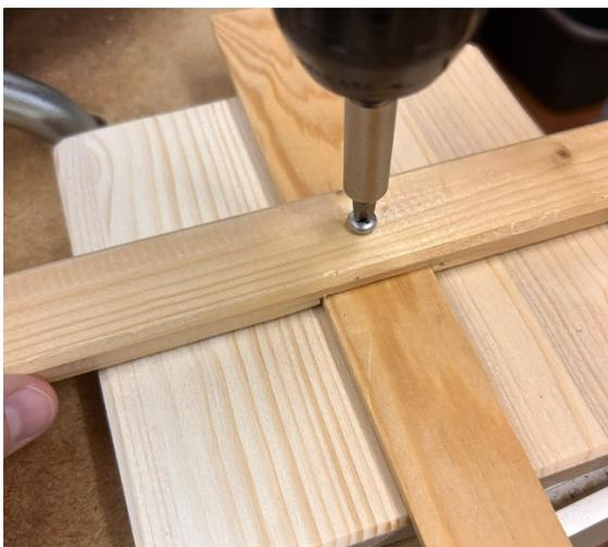
Abbildung 14: Verschrauben der Leisten mit dem Brett
