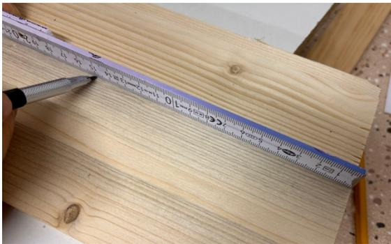
Abbildung 2: Anzeichnen der Schnittlinie
