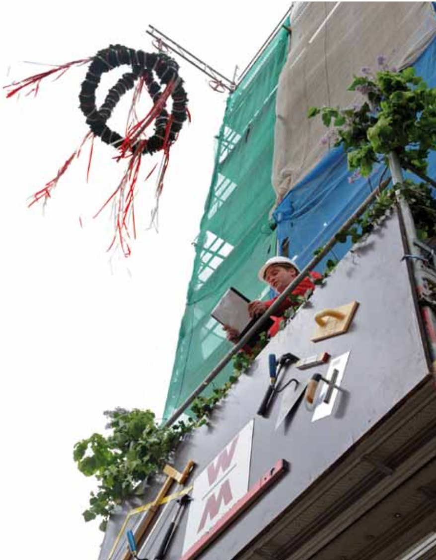
Richtkrone über dem Bibliotheksneubau: Künftig Platz für eine Million Bücher.
