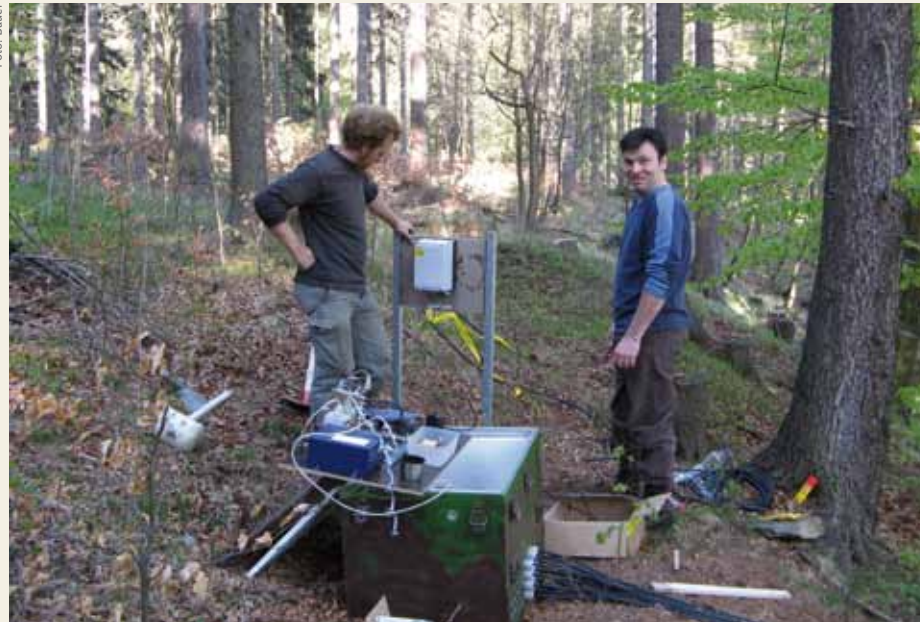
Anstrengend: Der Bodenfeuchtesensor will erst einmal installiert werden.
