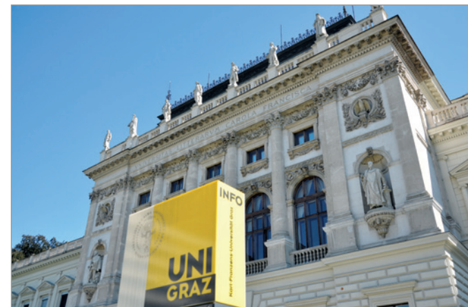
Hauptgebäude © Universität Graz
