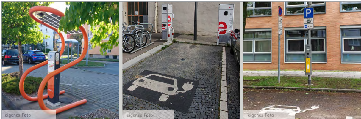
Abbildung 88 Beispielumsetzung E-Ladeinfrastruktur MIV
